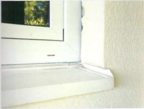
ილუსტრაცია 67: ფანჯრის პლასტიკური ჩარჩო ქვედა წყალსარინი ღიობით, წვიმისაგან უკეთესი დაცვისათვის, ფანჯრის რაფა აკეცილი უკანა მხარეს და წინა მხარე 20 მმ-ით გადმოშვერილია მობათქაშებულ ზედაპირზე. (ფოტო: თ. დუცია)
