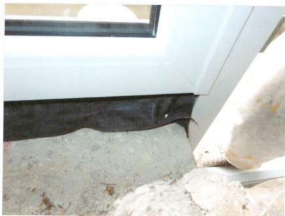
ილუსტრაცია 61: ახალი ფანჯარა „თბილი არშია“ კლასტმასის ფანჯრის წარიმანდში. ამგვარ კონსტრუქციაში ძალზე მცირეა თბური ხიდეების ეფექტი შეპირაპირების ადგილებში. (ფოტო: თ. დუცია)
