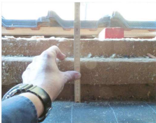
ილუსტრაცია 182: ნივნივების თბოიზოლაციისათვის გამოიყენეს 180 მმ სისქის შერენის ბოჭკოს თბოიზოლაცია. (ფოტო: პ.რაიფი)
