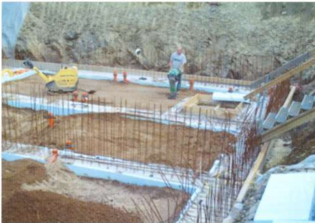
ილუსტრაცია 47: XPS-ის პერიმეტრული თბოიზოლაციის ლენტური საძირკველის გვერდების ორივე მხრიდან თბური ხიდების ზემოქმედების შესამცირებლად. (ფოტო: თ. დუცია)
