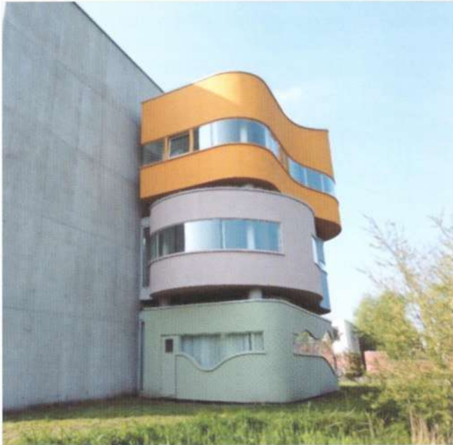
ილუსტრაცია 29: მკვეთრად დანაწევრებული საცხოვრებელი სახლი პროექტით განპირობებული მომატებული გარსის ფართობით, რაც იწვევს გაზრდილ ენერგოხარჯს. (ფოტო: თ. დუცია)
