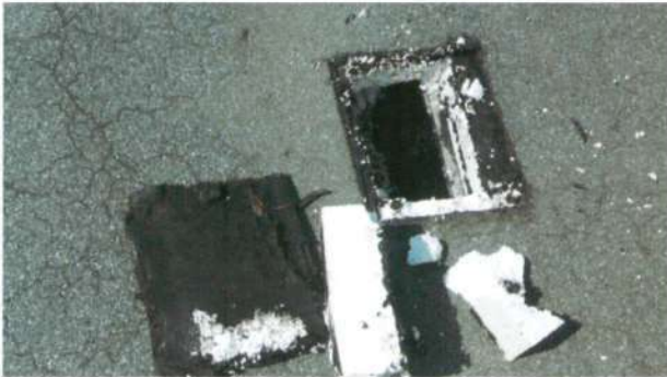
ილუსტრაცია 146: სამშენებლო ელემენტის გახსნა იზოლაციის სისტემის დასადგენად ბრტყელ სახურავში. (ფოტო: ჰ. რაიფი)
