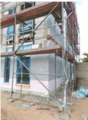
ილუსტრაცია 70: ფასადი პოლისტიროლის საიზოლაციო პანელებითა და მინერალური ბამბის ჰორიზონტალური სახანძრო ლარტყებით. (ფოტო: თ. დუცია)
