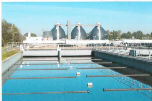
ილუსტრაცია 78: სამწმენდ ნაგებობაში ხრწნის შედეგად მიღებული აირის მომპოვებელი დანადგარი (წყარო: Shutterstock)
