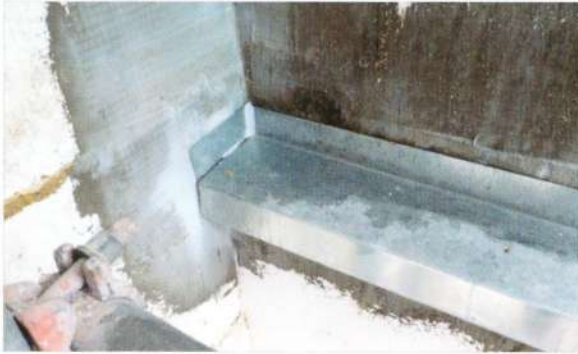
ილუსტრაცია 158: ხანგრძლივი დაცვა ნესტისაგან: კედლის შვერილზე მოთუთიებული თუნუქის დამონტაჟება. (ფოტო: პ.რაიფი)
