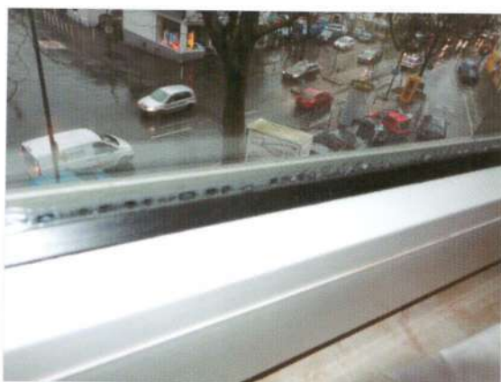
ილუსტრაცია 62: ფანჯარა კონდენსატით მინის კიდიდან და ალუმინის წარიმანდის მოსაბღვრე არეში. ალუმინის მაღალი გამტარობა იწვევს დაბალ ზედაპირულ ტემპერატურას ნაპირებში. (ფოტო: თ. დუცია)
