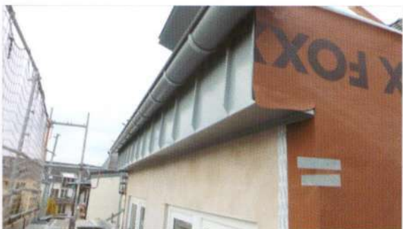
ილუსტრაცია 165: სახურავის ლავგარდანის თბოიზოლაცია ამ სითბური ხიდის შესამცირებლად. (ფოტო: პ. რაიფი)
