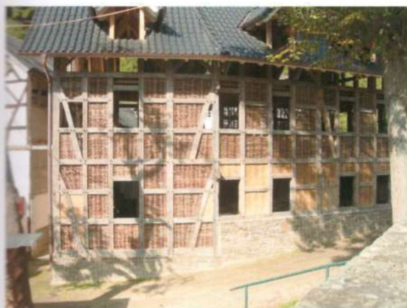
ფოტოსტრასია 23. ფახვერკის ტიპის სახლის ტრადიციული კარკასი ხის საყრდენებით, რიგვლებითა და ჩალანგარით (ფოტო: თ. დუცია)
