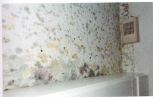
ილუსტრაცია 64: ობის სოკო მასიურ და არაიზოლირებულ გარე კედელზე, რაც მაცხოვრებლის არასწორი ჩვევებით, განპირობებული ჰაერის მაღალი ფარდობითი ტენიანობით არის. გამონეკელი (ფოტო: თ. დუცია).
