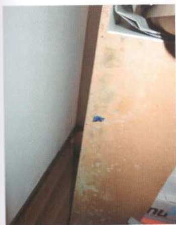
ილუსტრაცია 63: ობის სოკო კარადის უკანა მხარეს, რომელიც ძალიან ახლოს იყო მიდგმული ცივ გარე კედელთან, რომელზეც გაჩნდა კონდენსატი. (ფოტო: თ. დუცია)
