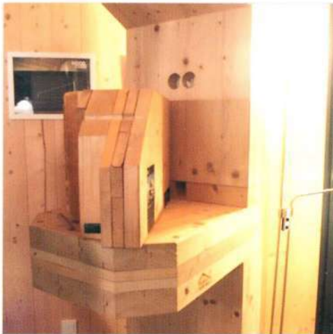
ილუსტრაცია 223: გარე კედლის სტრუქტურა ნებოსა და ხრახნის გარეშე (ფოტო: მაიერ-გ. ბ.დ.)
