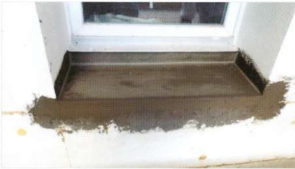
ილუსტრაცია 159: აივნის შვერილებზე დამატებითი ჰერმეტიზაცია წვიმისაგან დასაცავად ცემენტ-სინთეტიკური ჰერმეტიკული დუღაბით და ელასტიკური ქსოვილის შუასადებით (ბადისებრი ქსოვილი). (ფოტო: პ.რაიფი)
