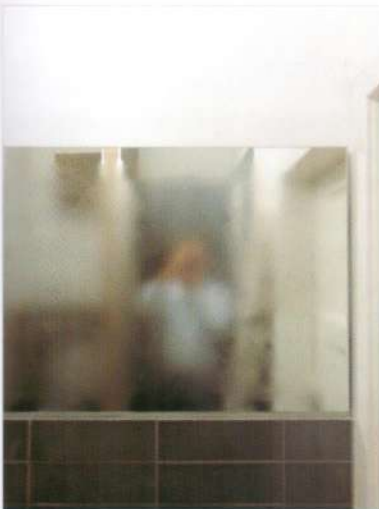
ილუსტრაცია 59: ხილული კონდენსატის წარმოქმნა სარკეზე და უხილავი ნესტის განლაგება მობათქაშებულ ზედაპირებზე. (ფოტო: თ. დუცია)
