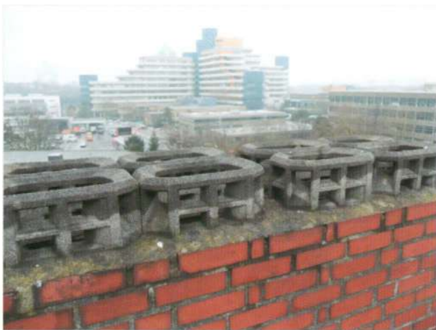
ილუსტრაცია 144: ვენტილაციის სითბური დანაკარგები ვენტილაციის არხებიდან. (წყარო: 3, რაიფი)
