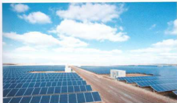
ილუსტრაცია 128: მზის ფოტოელექტრული სადგური მყარად დამონტაჟებული ფოტოვოლტაიკის პანელებით (წყარო: iStock)
