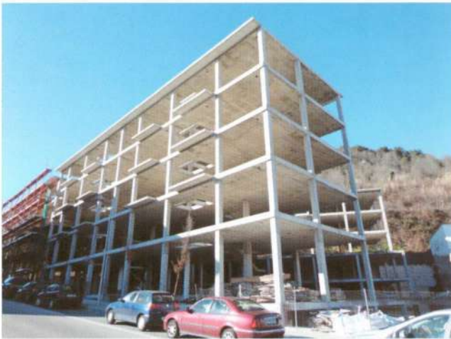
ილუსტრაცია 22: საცხოვრებელი სახლის კარკასი ქ. ოლოტში/ესპანეთი, აშენებული კარკასული კონსტრუქციით, ბეტონის საყრდენებითა და მონოლითური ღრუ ბლოკის ქვით (ფოტო: თ. დუცია)
