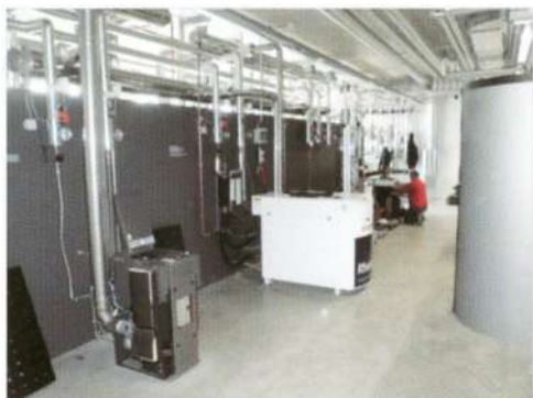
ილუსტრაცია 230: სითბო-ელექტრო ბლოკური სადგურები (BHKW). (ფოტო: ი. ფომ შტაინი)
