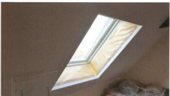
ილუსტრაცია 166: ორთქლის შემაკავებელი აფსკის შეერთება დაქანებულ ფანჯარასთან. (ფოტო: პ. რაიფი)
