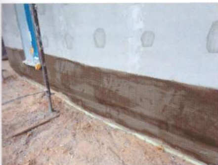
ილუსტრაცია 68: ჰერმეტიზაცია პერიმეტრის თბოიზოლაციაზე და ბათქაშზე, მობათქაშებული ფასადის დასაცავად. (ფოტო: თ. დუცია)
