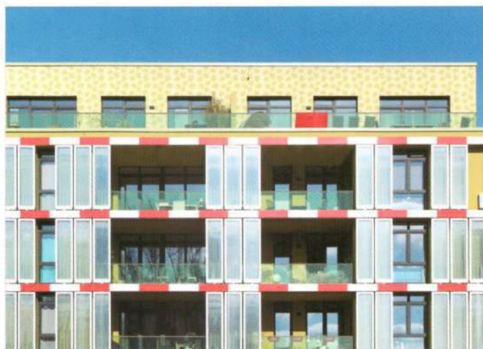
ილუსტრაცია 224: წყალმცენარეების სახლის ბიორეაქტორული ფასადი ქ. ჰამბურგში. (წყარო: iStock)
