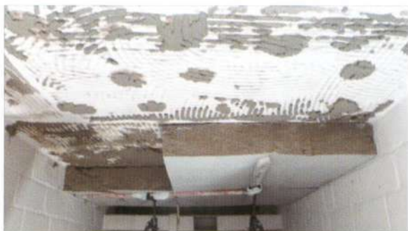
ილუსტრაცია 163: ნებო-ცემენტის ნარევი არასაკმარისი შეჭიდება-დობით. (ფოტო: პ. რაიფი)
