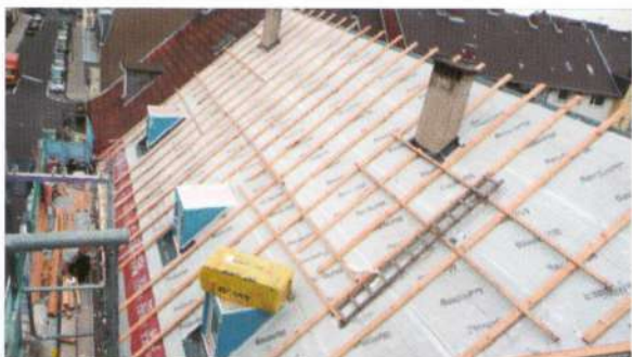
ილუსტრაცია 164: უწყვეტი ქარგამ-ძლე სიბრტყე; სამერცხლისა და საკვამურის შეერთებების მოქცევა ჰერმეტიზაციის კონცეფციაში. (ფოტო: პ. რაიფი)
