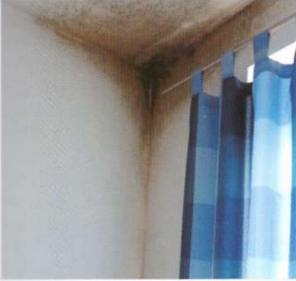
ილუსტრაცია 39: საშგანზომილებიანი თბური ხიდი ოთახში. კუთხის არეში დაბალი ზედაპირული ტემპერატურის გამო ჩნდება კონდენსატი, რაც მისი დაობების საფუძველს წარმოადგენს. (ფოტო: თ. დუცია)
