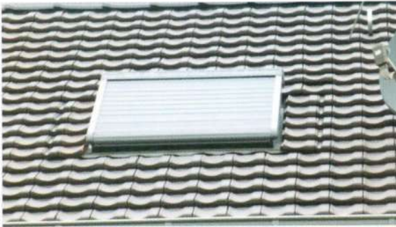
ილუსტრაცია 167: გარე ჯალუზზე დამონტაჟებული ფოტოვოლტაიკის პანელები. (ფოტო: პ. რაიფი)
