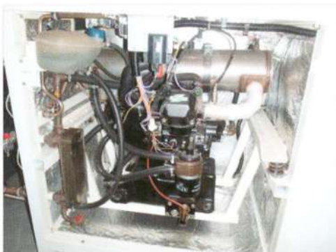
ილუსტრაცია 230: სითბო-ელექტრო ბლოკური სადგურები (BHKW). (ფოტო: ი. ფომ შტაინი)
